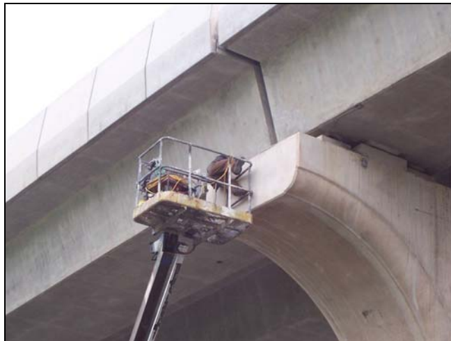
圖 4 身體過度延伸於欄杆外作業
