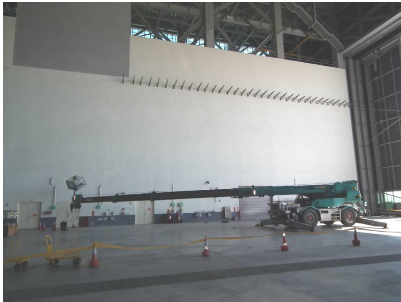
照片說明：災害時移動式起重機吊桿伸長情形
