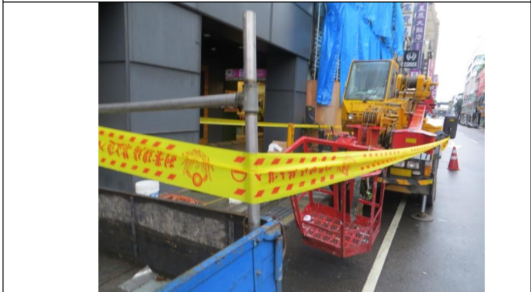
照片說明：移動式起重機及搭乘設備
